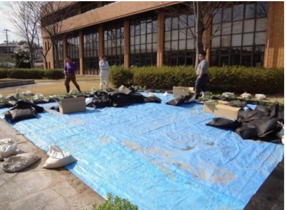
本宮市役所の広場に汚染土壌が埋設してあり、ブルーシートで覆われている。 常緑キリンソウ普及協会メンバーによる常緑キリンソウ袋方式の設置作業。
