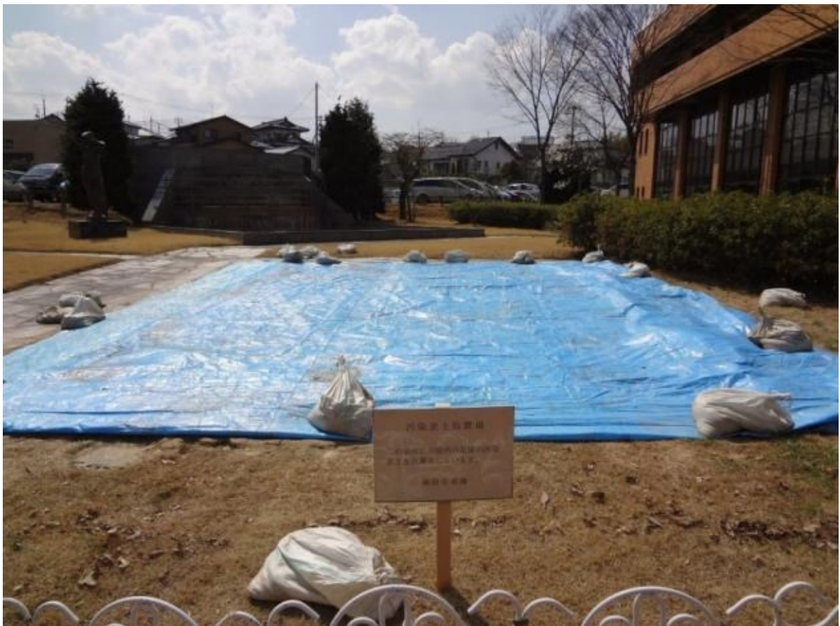
福島県本宮市役所 2012 年 4 月 19 日 (施工前)
