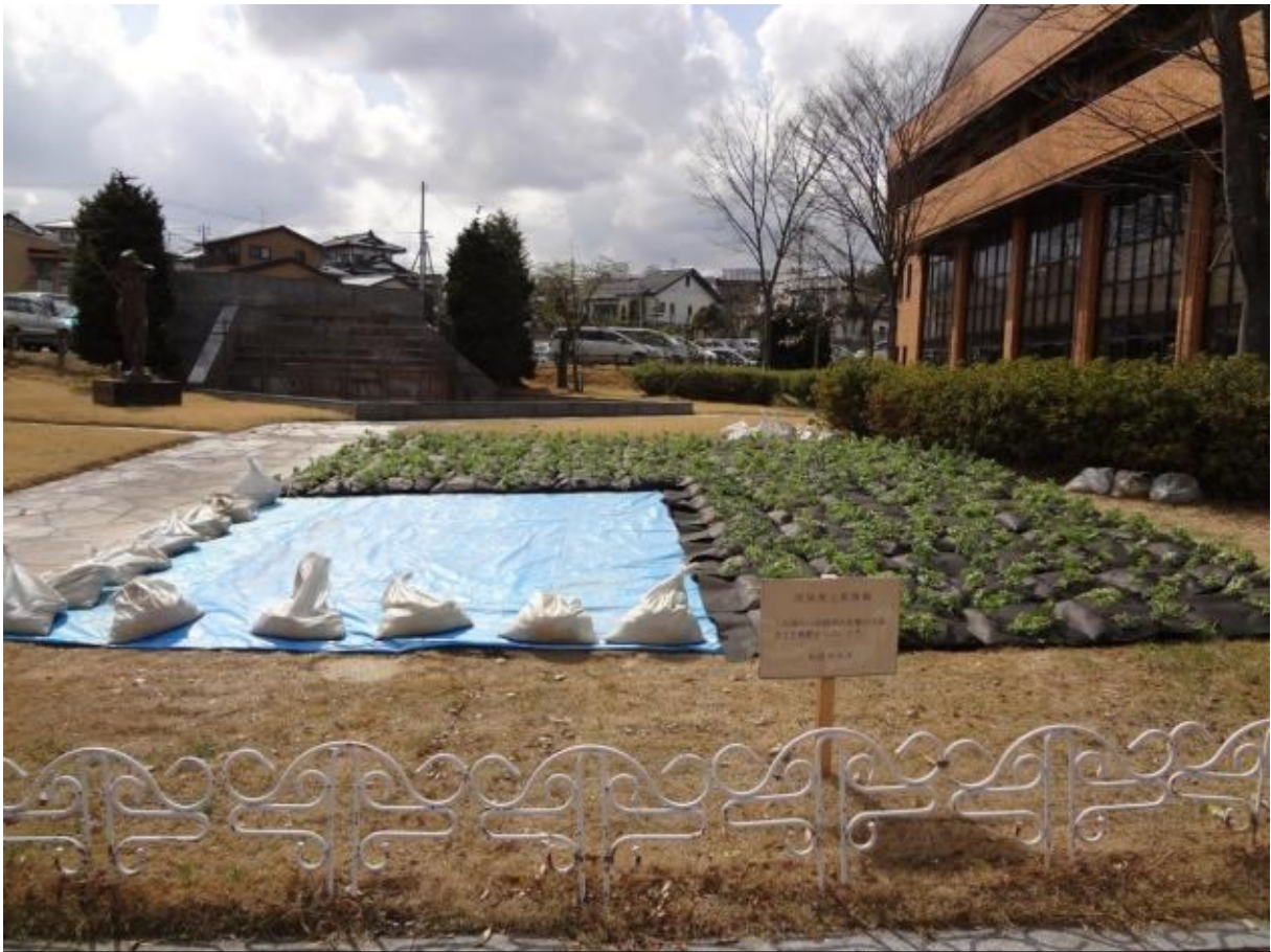
福島県本宮市役所 2012年4月19日（施工中）
