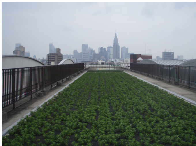
2009年6月10日(3月に施工 土壌が見える)
